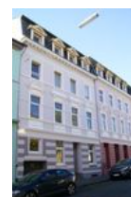
Fassadensanierungsprogramm: Die neuen Objekte wurden direkt in frische Farben gehüllt: Eichenstraße 56-58
