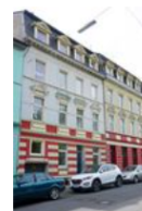
Zwei auf einen Streich! Das 100. Objekt war zugleich das 101.: Eichenstraße 56-58
